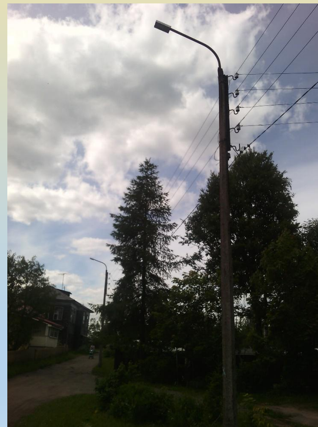
Общественная территория после выполнения работ
