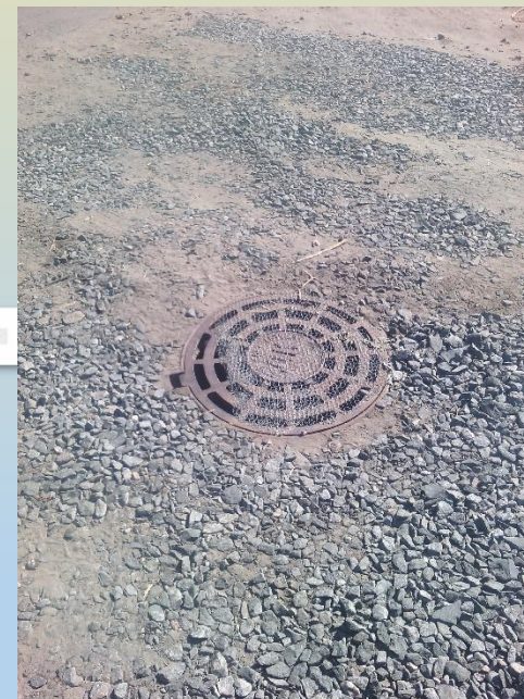
Общественная территория после выполнения работ
