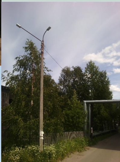
Общественная территория после выполнения работ
