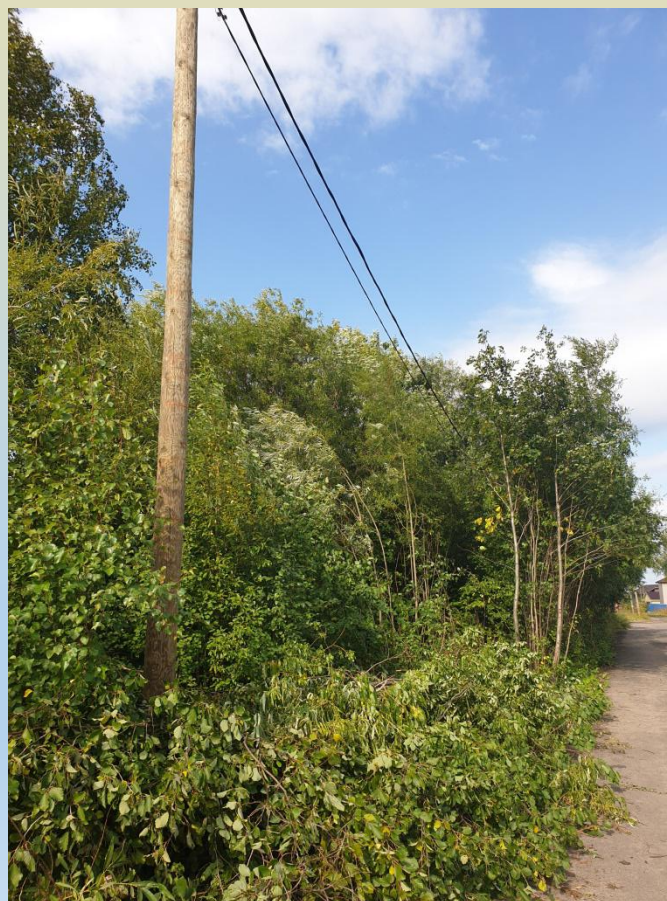
Общественная территория во время выполнения работ
