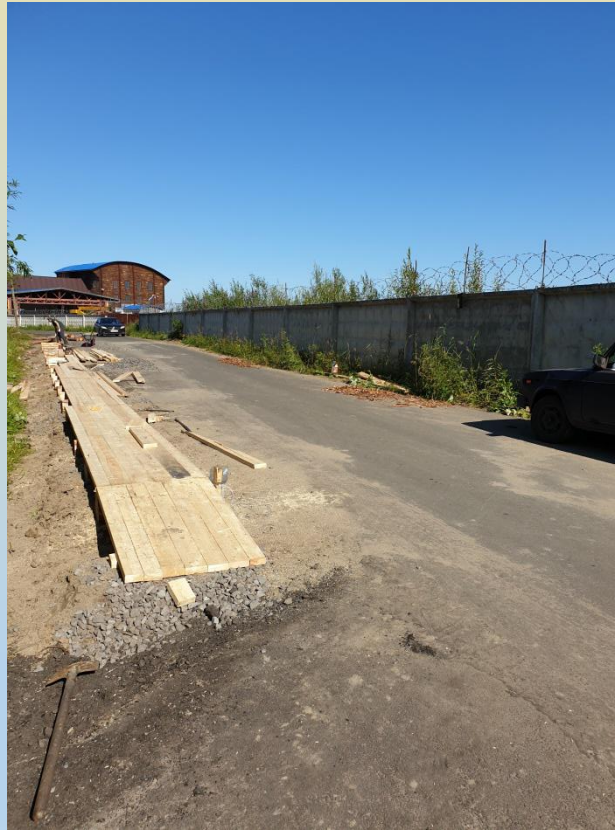
Общественная территория во время выполнения работ
