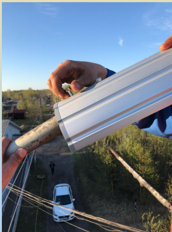
Общественная территория во время выполнения работ
