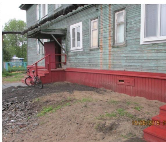
Капитальный ремонт дома №19 (после пожара) по ул. Центральная п. Лайский Док выполнен на сумму 747 020,55 рублей (уборка мусора после пожара, частичный ремонт помещений после пожара, установка оконных блоков, замена
